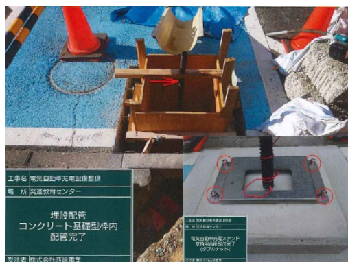
電気スタンド基礎工事
