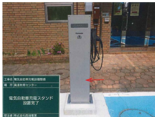
建物に電源取付 電気スタンド取付
