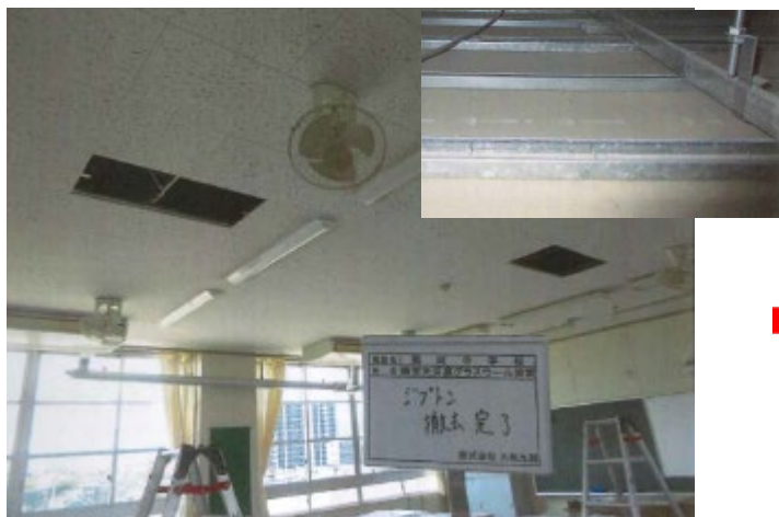
断熱材を敷きこむために、天井の一部を取り外します。
