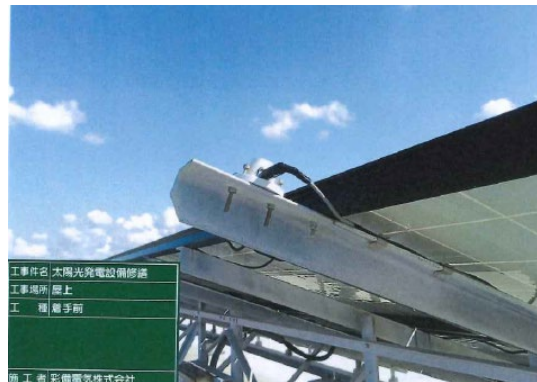
日射計 交換 着手前
