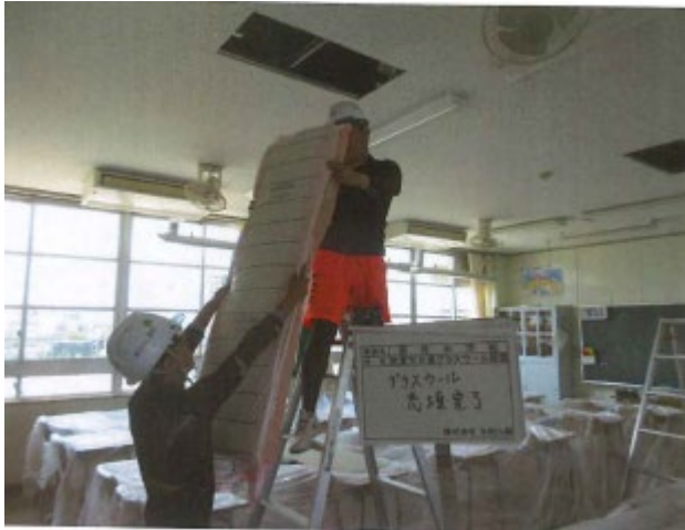
断熱材の搬入状況です
