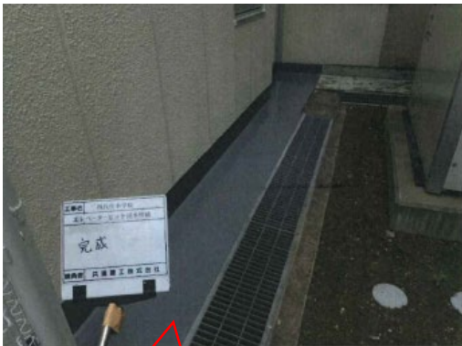
土間部分に新たに防水施工
