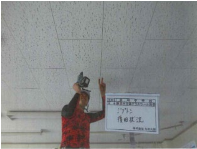
断熱材を敷きこむために、天井の一部を取り外します。
