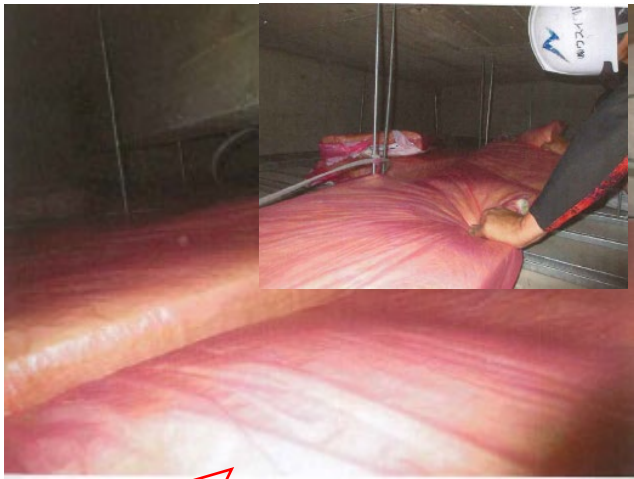
断熱材の敷き込みを行いました
