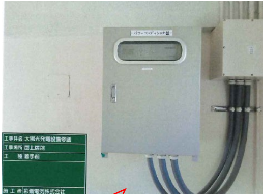
パワーコンディショナー交換 着手前
